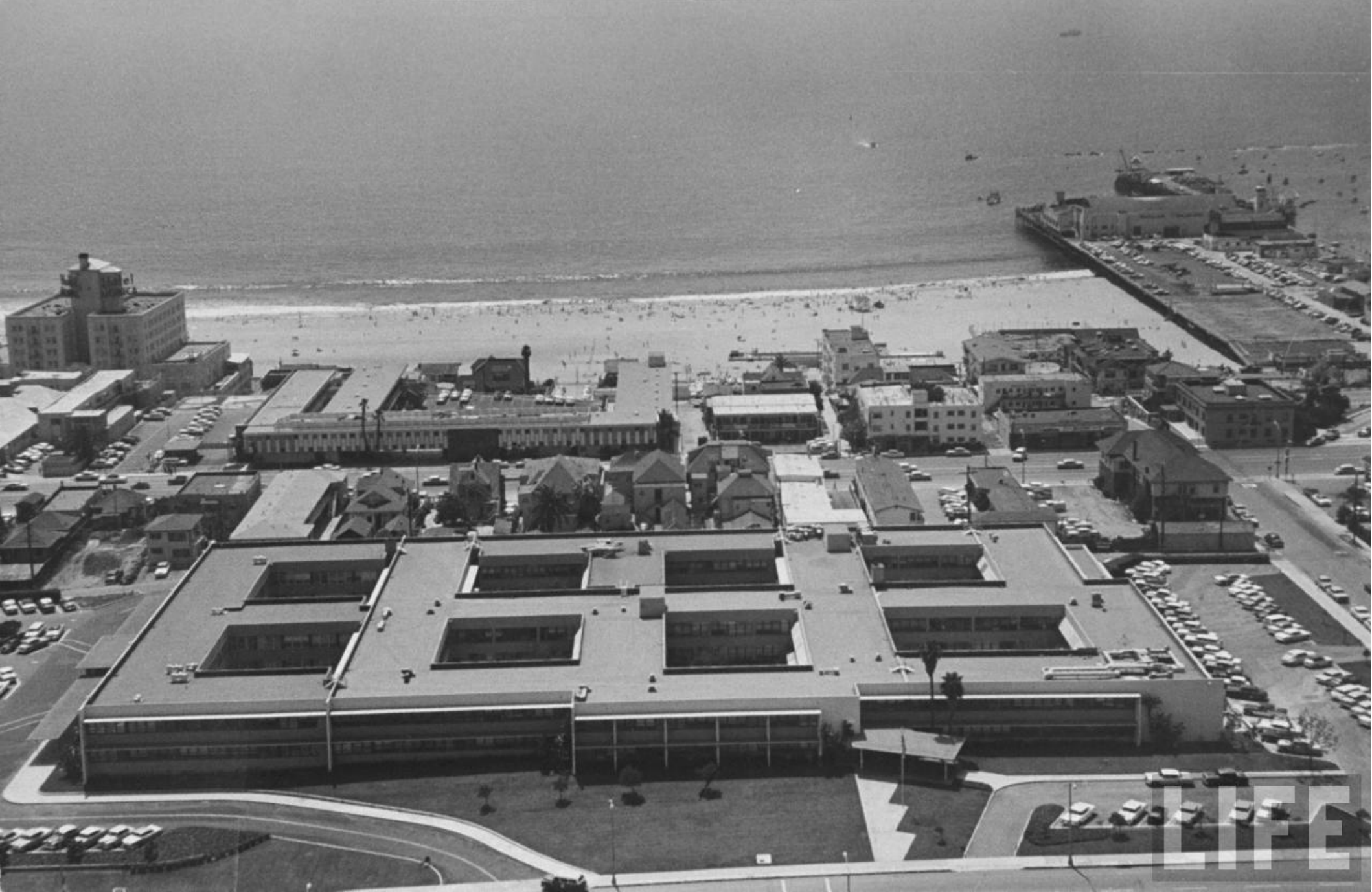
Edificio de la Rand Corporation, Santa Mónica; California ca. 1953; imagen, 1958
