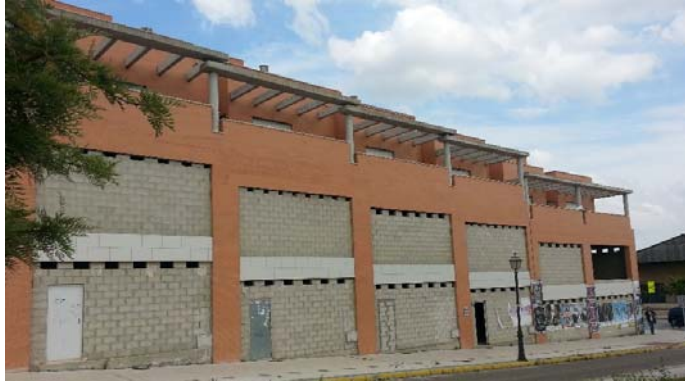
Edificio en bloque de 7 viviendas en esta misma zona, también completamente vacío, de media 110 m 2
