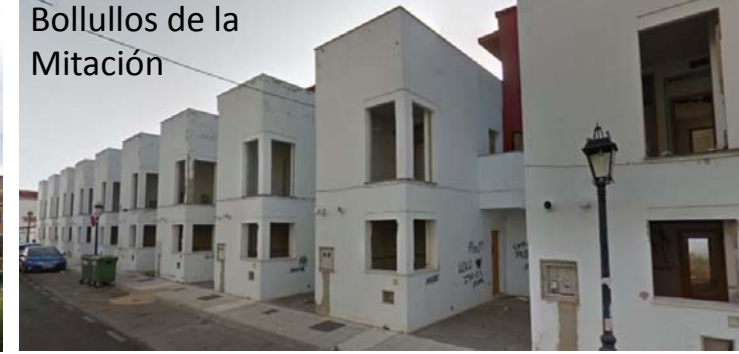
Conjunto de 10 viviendas unifamiliares vandalizadas en calle Calvario con superficie construida media de 156 m 2
