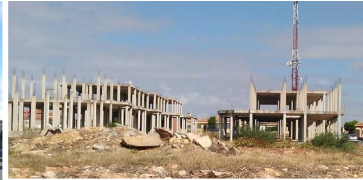
Promoción fallida que se encuentra en esqueleto estructural, destinado a albergar 63 viviendas unifamiliares en el nuevo sector PP-R2
