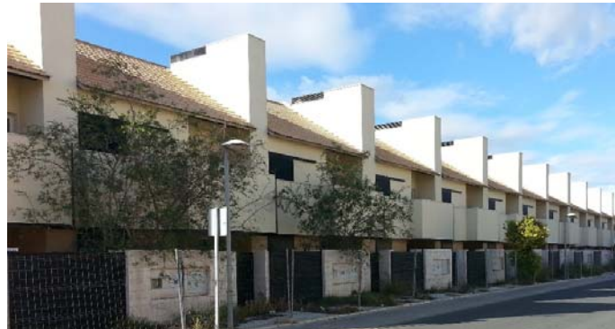
Conjunto de 18 viviendas unifamiliares en la zona de La Florida de media 250 m 2
