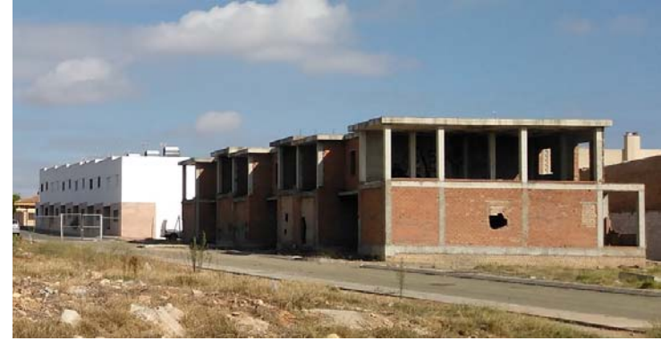
Promoción fallida que se encuentra en esqueleto estructural, destinado a albergar 63 viviendas unifamiliares en el nuevo sector PP-R2
